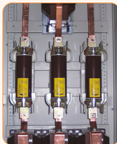
Położenie wkładek topikowych zamontowanych na zewnątrz.*
